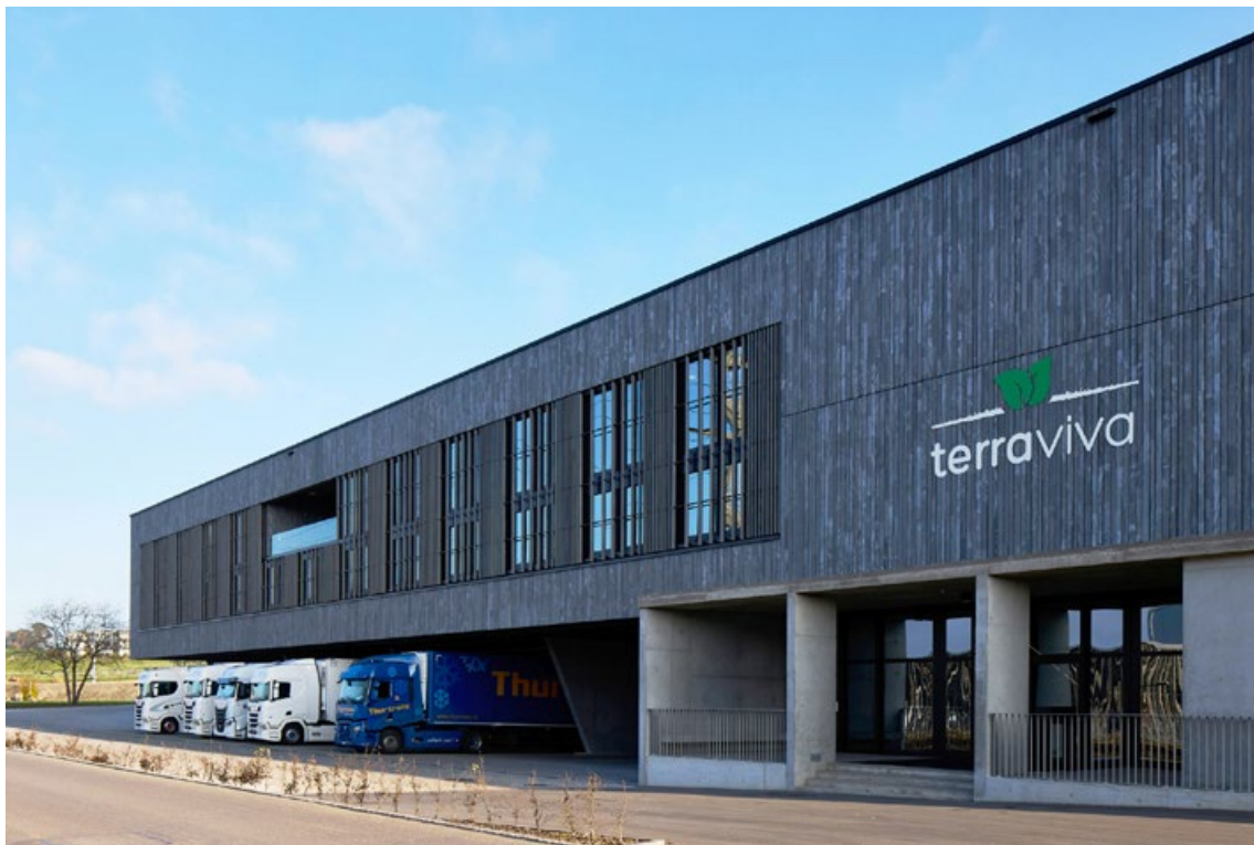
Choisir des matériaux locaux: Les 3500 mètres carrés de façades n'ont été habillés qu'avec du bois suisse.
