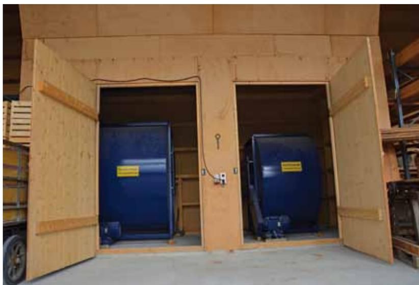
Les ventilateurs aspirent l'air chaud sous le toit d'éternit et le refoulent dans les deux cellules de séchage et de stockage.
