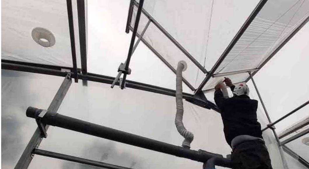
Abbildung 6 Folienhaus mit aufgeblasener Doppelfolie [Quelle: [www.gvz-rossat.ch](http://www.gvz-rossat.ch)]
