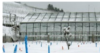
Les serres peuvent être gourmandes en énergie.
